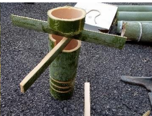
写真：竹材を活用したスパーサー（竹筋コンクリート）
