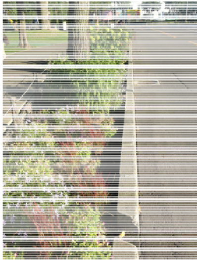
雨水貯留機能を備えた植栽帯（左札幌市 右京都市）
