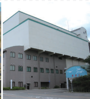
米子市クリーンセンター
