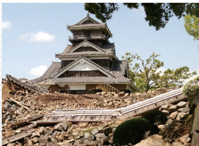
熊本地震被害の様子
