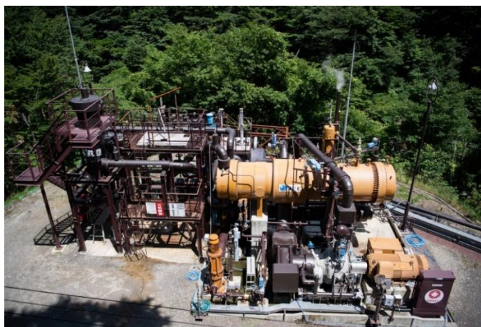
図 3-36 (株)元気アップつちゆのバイナリー発電施設
