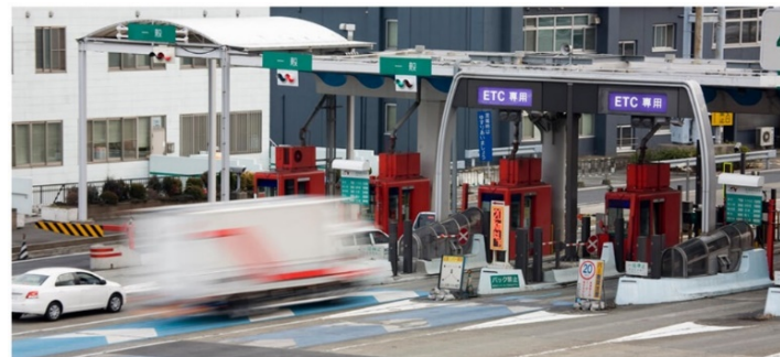
自動運転、ICT、IoT等の最新技術の研究を通じ、新たな道路環境のあり方、地域創生に資する地域公共交通網のあり方を追求します。
