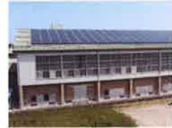
中海テレビ放送太陽光発電 米子北斗中学校、高等学校 (米子市夜見町)
