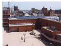
東洋ソーラー米子市立図書館 太陽光発電所(米子市中町)
