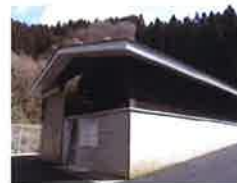
企業局若松川発電所 (日野郡日南町)
