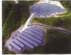
八王寺工業ソーラー米子発電所 (西伯郡南部町)
