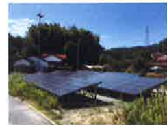
東洋ソーラー福原西太陽光発電 実験施設(松江市福原町)
