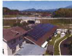
中海テレビ放送太陽光発電 わかとり作業所(西伯郡南部町)
