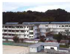
東洋ソーラー米子市尚徳中学校 太陽光発電所(米子市日原)
