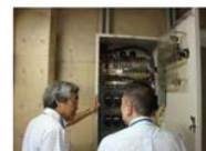
CO 2 削減ポテンシャル診断 事業 (平成 26 年度) *省エネ診断調査
