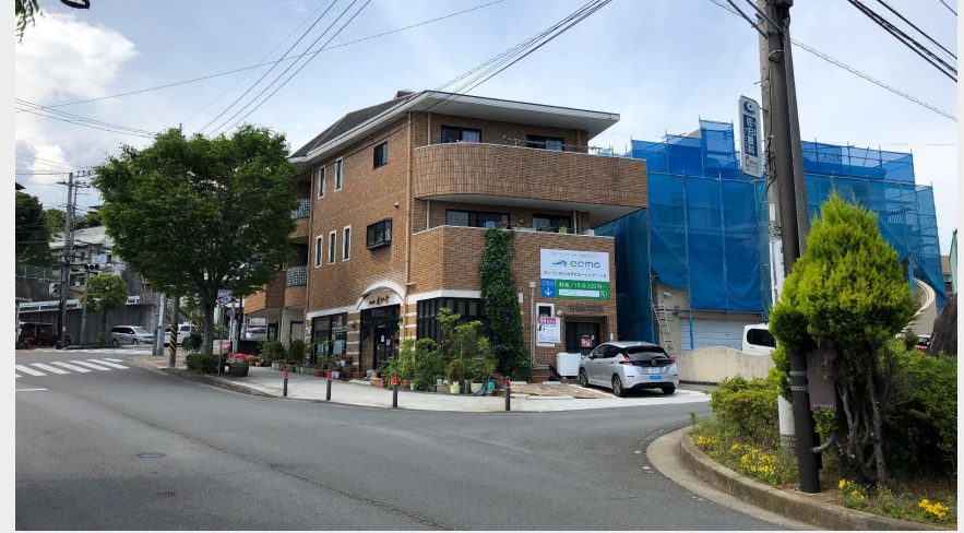
城山第一ステーション
