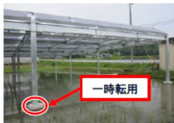
▲ 営農型太陽光発電設備の例
