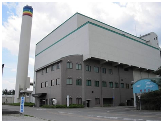
写真. 米子市クリーンセンター
