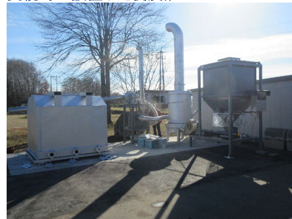
美幌町に設置した製炭炉
