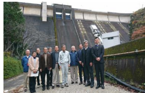
天理ダム視察(小水力発電)
