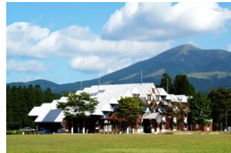
木魂館（研修宿泊施設）
