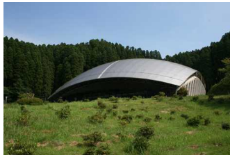
小国ドーム（町民体育館）
