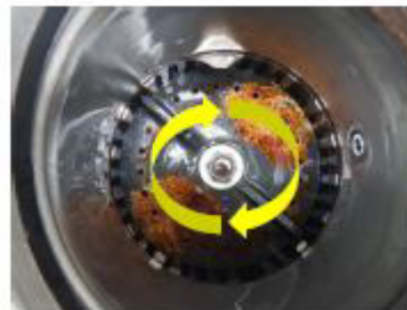
【写真4】排水溝内部
